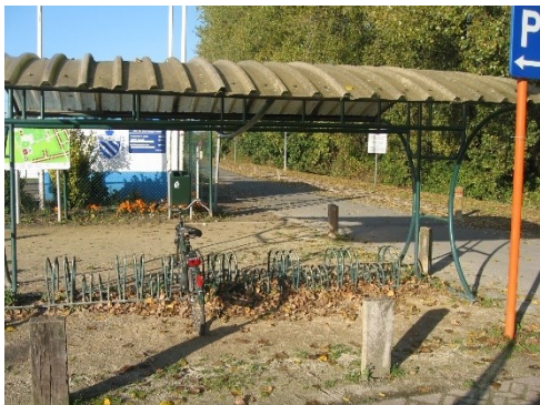
fietzenstalling zonder aanbindmogelijkheid: niet ok
