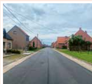
De nieuwe asfaltlaag in de Aststraat
