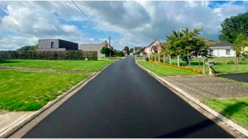
De nieuwe asfaltlaag in de Smoutstraat
