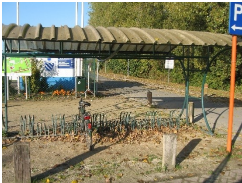
fietsenstalling zonder aanbindmogelijkheid: niet ok
