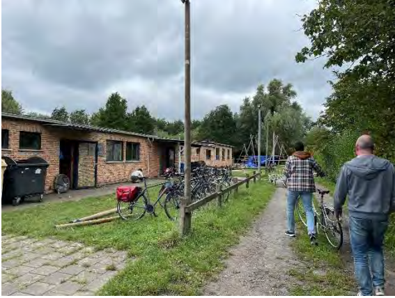
Scoutslokaal vanop het grindweggetje dat de ontsluiting verzorgt met de Tybaertstraat
