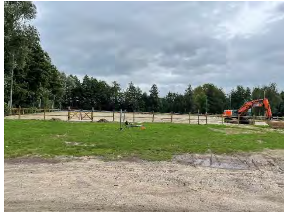
De piste langs de Stationsstraat, momenteel deel van de constructiesite voor de aanleg van de twee nieuwe parkzones.
