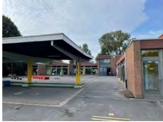
Zicht op een deel van de speelplaats, met centraal een grote overkapping.
