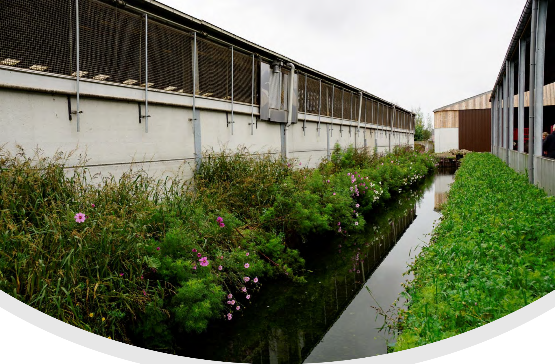
Hemelwaterinfiltratie – F. Hermans (Sluisstraat)
